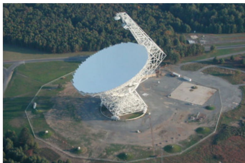
2. 100x110 m czasza teleskopu GBT Narodowego Obserwatorium Radioastronomicznego (USA). Antena paraboliczna, offsetowa porusza się w azymucie i wysokości podobnie do anteny z Effelsberg. Jest bardzo ciężka i bardzo droga. Długie ramię podpierające lustro wtórne i utrzymujące systemy odbiorcze sprawia poważne kłopoty eksploatacyjne. Aktywna powierzchnia reflektora głównego umożliwi pracę do 100 GHz. Proponowana 90-m antena polskiego radioteleskopu będzie prawie 10-krotnie lżejsza i 10 razy tańsza
