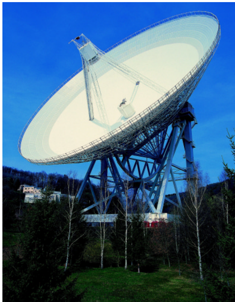
1. 100-m średnicy radioteleskop w Effelsberg należący do Max-Planck Institut fuer Radioastronomie (Niemcy). Nowy polski 90 m radioteleskop będzie miał czaszę reflektora podobnej wielkości, ale w pełni pokrytą panelami z cienkiej blachy aluminiowej. W proponowanej konstrukcji 90 m radioteleskopu nie będzie skomplikowanych i drogiej napędów ruchu w azymucie i wysokości
